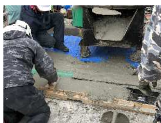
伸縮装置取換え工事の様子
