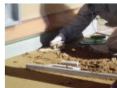
・たたきくん下塗材を塗付け後、たたきくん下塗材が乾ききらないうちに追っかけて、たたきくんを所定の厚み(8mm程度)まで十分にコテ圧を掛けて金ゴテで平滑に塗り付けてください。
