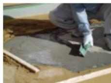
・吸水調整の完了した下地に、たたきくん下塗材を十分にコテ圧をかけてしごき塗りを行い、追っかけてすぐに、2mm程度の厚みまで塗り付けてください。
