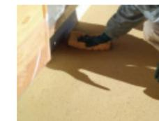
・たたきくんの表面の砂くずが乾燥して(砂くずの色が白くなって)きたら水を含ませてかたく絞ったスポンジで同一方向にきれいに拭き取り、砂目を出して仕上げてください。
