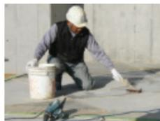
・左官刷毛等を使用し、施工面全面にユニレックス3の5倍希釈液にて、吸水調整を行なってください。
