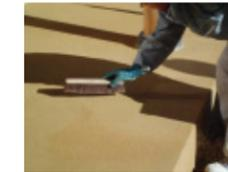
・最後に拭き上げた時点から10～30分程度経過後、表面に残った砂くずを乾いた左官刷毛等で、軽く取り除いてください。
