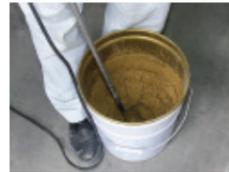
・たたきくに規定量の水道水(1.8～2.0ℓ/袋)を加え、モルタル用かくはん機等を用いて十分に混練してください。
