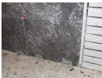
石材の仮止め
