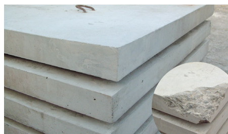
欠損部補修・角おこし(コンクリート・ALCなど)
