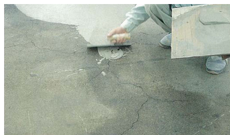
1～3mmの部分補修材として使用出来ます。
