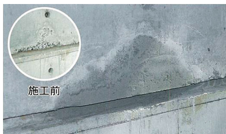
現場打ちコンクリートのジャンカ補修・孔埋め
