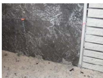
石材の仮止め
