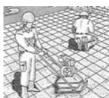
④転圧による目地詰め
